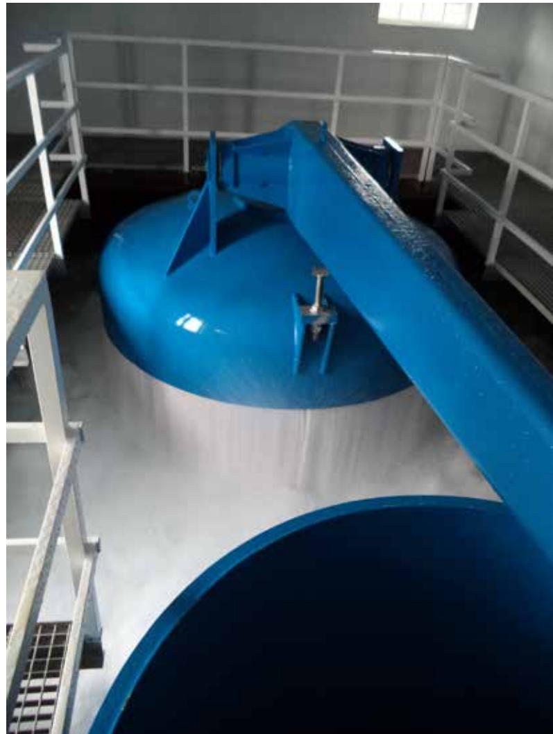
▲ Válvula de rotura de carga.
