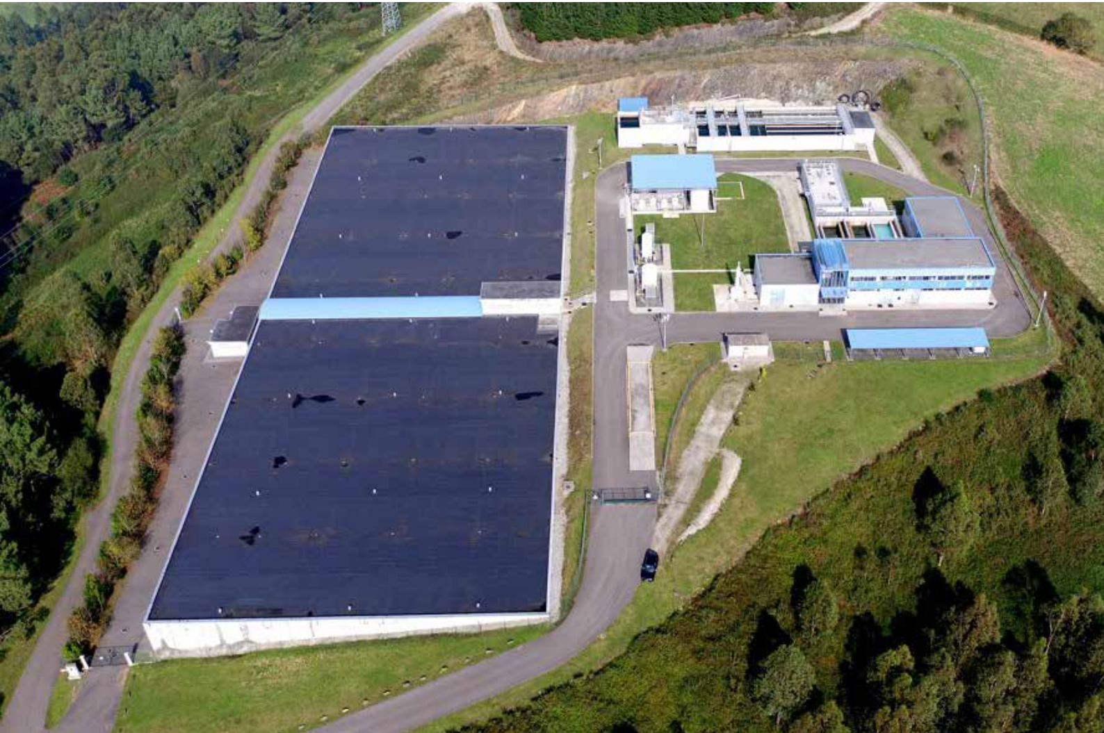
↑ ETAP y depósito de Arbón.
