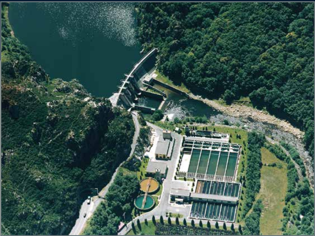
Embalse de Rioseco. Estación de tratamiento de agua potable de Rioseco.
