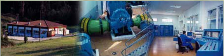
Estación de bombeo de Ablaneda.
