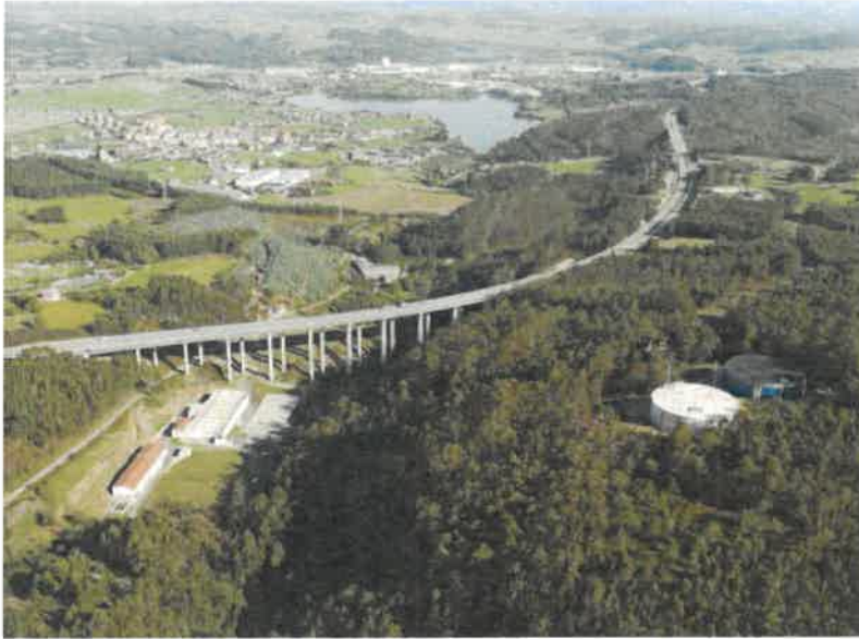
Etap de Ablaneda y depósitos de Núñez.
