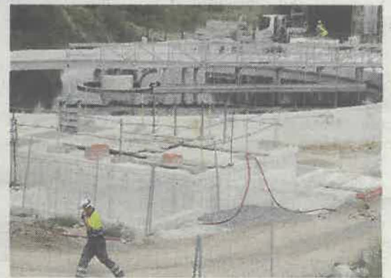
Obras en la depuradora de San Claudio.
