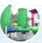
Caldentres antiariente en la ETAP de Albande (Covares)
