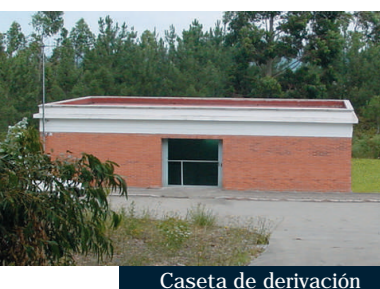
Caseta de derivación
